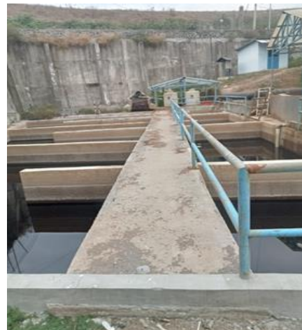
Kegiatan pemeliharaan kolam air lindi berupa pengurasan bak koagulan bulan Juli 2024
